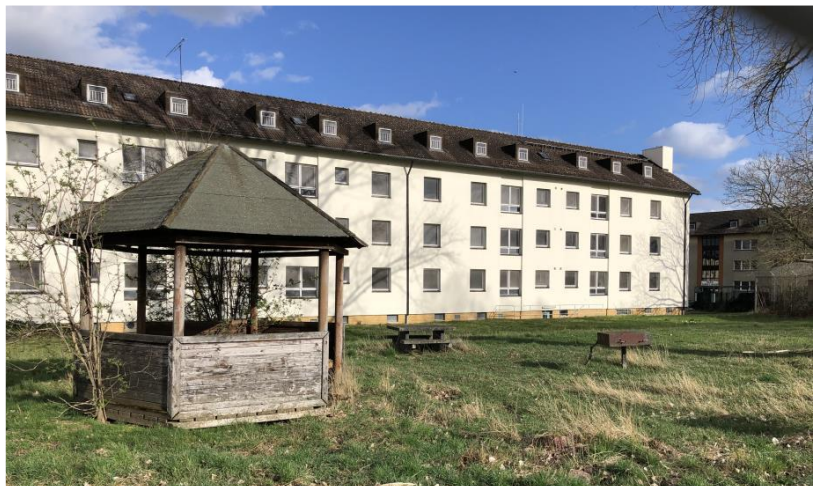
Gut erhaltener Wohnraum im PHV – 2004 renoviert und jetzt dem Abbruch geweiht???
